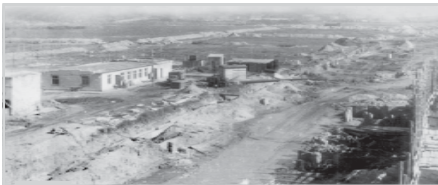
Временный склад, где размещалась дирекция строящегося завода
