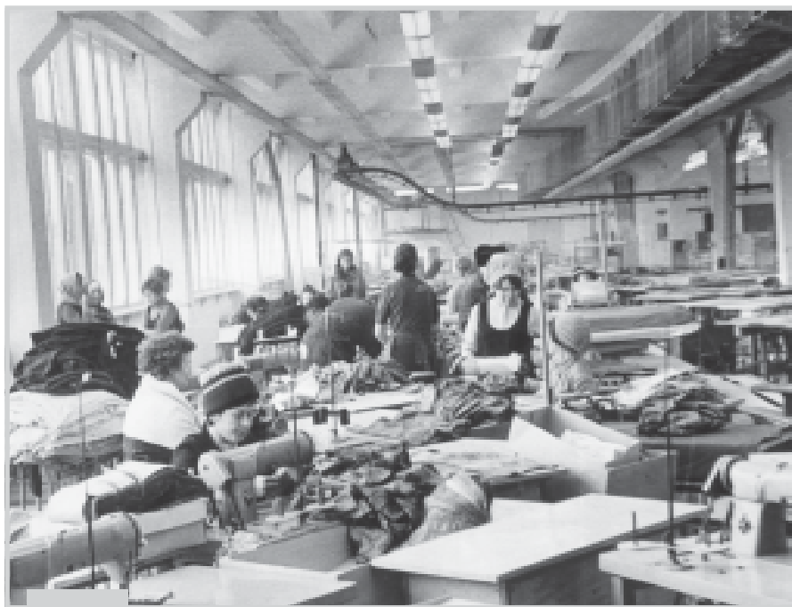
Цеха, оснащенные «дедовским» оборудованием с трансмиссионными передачами к двигателям станков
