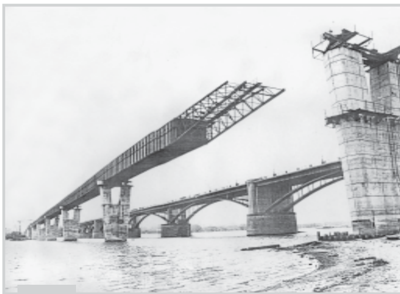
Строительство метромоста через Обь в Новосибирске
