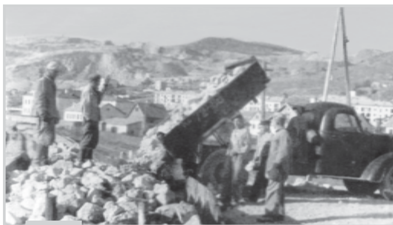
Строительство переправы через Керченский пролив
