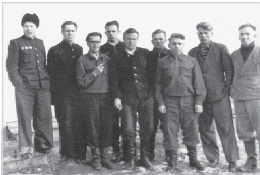
Мостостроители строительно-монтажного поезда № 403
