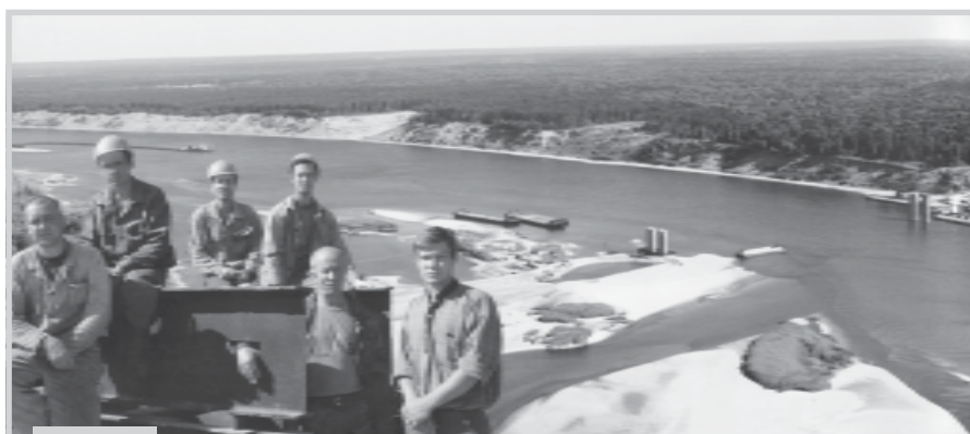
Строительство Северного обхода через Обь
